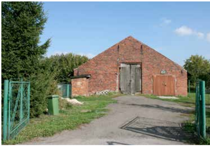
ehemalige Schmiede (M.S., September 2012)
